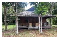
Bangunan Rumah Penjaga
